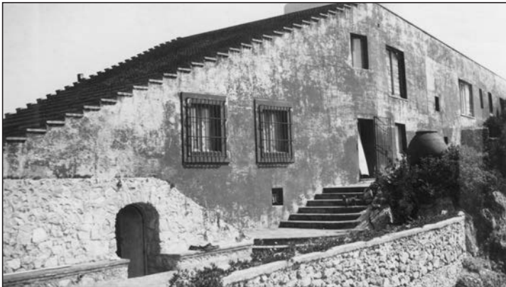
Façade de la Casa Come Me
